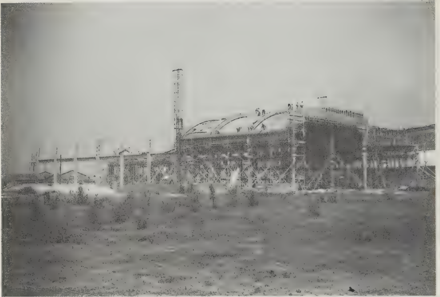
La fábrica de caños SIAT, en construcción en 1948, que no llegó a ver finalizada.
