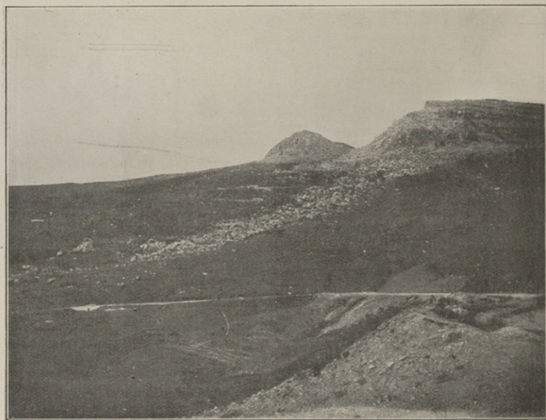
FIG. 4. — ÉBOULEMENT DU MONTE CAMPO. Reproduction d'une photographie de M. S. Squinabol.
