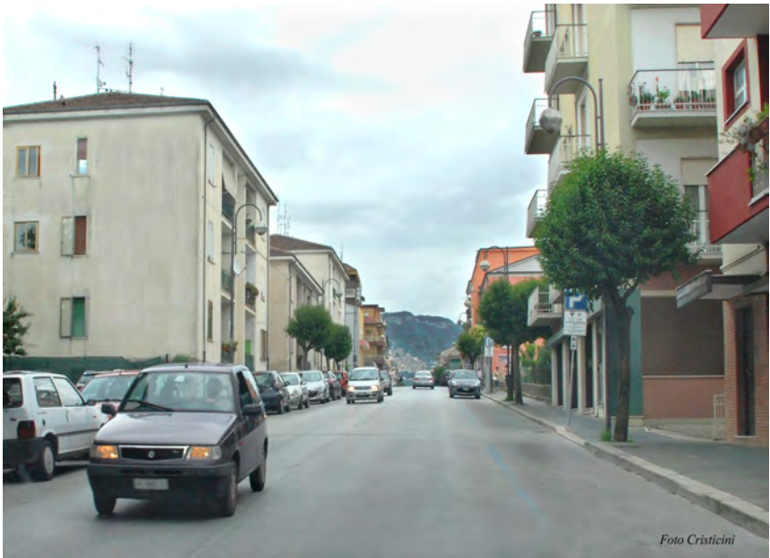
6 - 7 - 8 Cantiere e edifici di case popolari costruiti da Vittorino, Corso Risorgimento.
